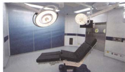
治療上の必要性に応じ、手術台などの部品は、着けたり外したり交換したりができる
